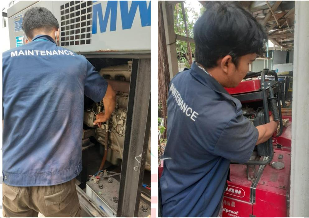
**Gambar 3.3 Perawatan dan Perbaikan unit genset**
