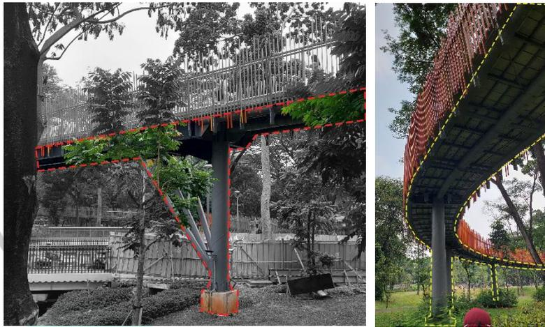
Gambar 4. 4 Struktur jembatan
