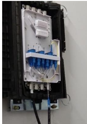
Gambar 3. 35 Hasil Pemasangan Passive Splitter 1:16
