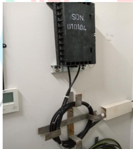
Gambar 3. 34 Hasil Pemasangan DP beserta X-Frame pada Ruang Shaft
