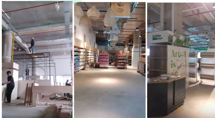
Gambar 3. 15 Progres Pembangunan Mbloc Market Semarang Sumber : Dokumen Prusahaan, 2023
