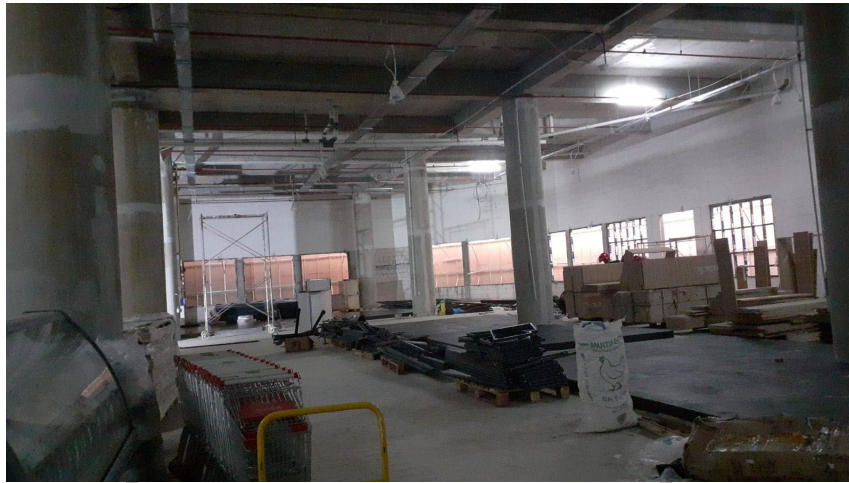
Gambar 3. 14 Foto Progres Kemajuan Pembangunan Mbloc Market Semarang Sumber : Dokumen Kontraktor, 2023
