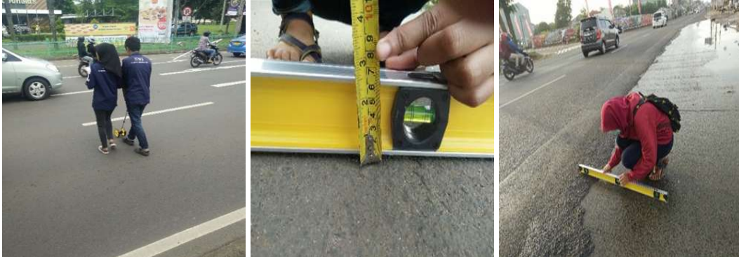
Gambar 1.5 Survei Pengukuran Geometrik Jalan
