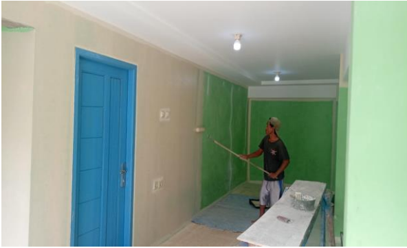
(a) Proses pengecatan ulang dinding dalam
