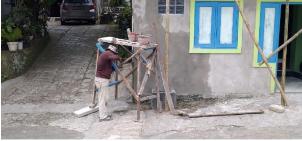
(a) Pekerjaan pengacian dinding luar
