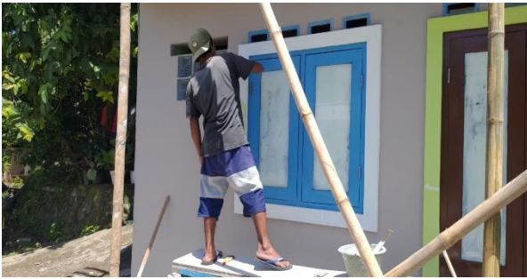
(b) pekerjaan pengecatan kusen
