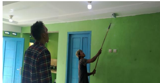
(c) Pekerjaan Pengecatan penutup plafond
