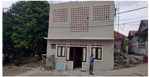
(c) Hasil akhir pekerjaan eksterior
