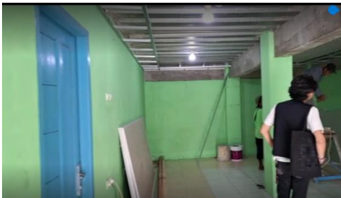
(a) Pekerjaan pemasangan rangka plafond
