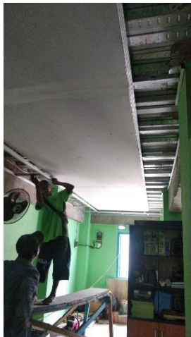
(b) pekerjaan pemasangan plafond
