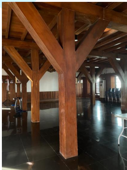
Gambar 4. 28 Pilar Kayu yang Sudah Diganti
