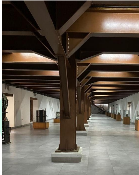
Gambar 4. 29 Pilar Besi pada Gedung C
