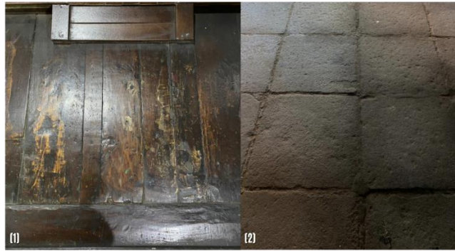
Gambar 4. 23 (1) Material Lantai Batu Alam dan (2) Material Lantai Kayu
