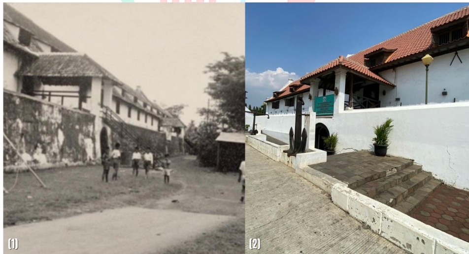
Gambar 4. 15 (1) Tinggi Pintu Masuk Museum Bahari Zaman Dahulu (2) Tinggi Pintu Saat Ini
