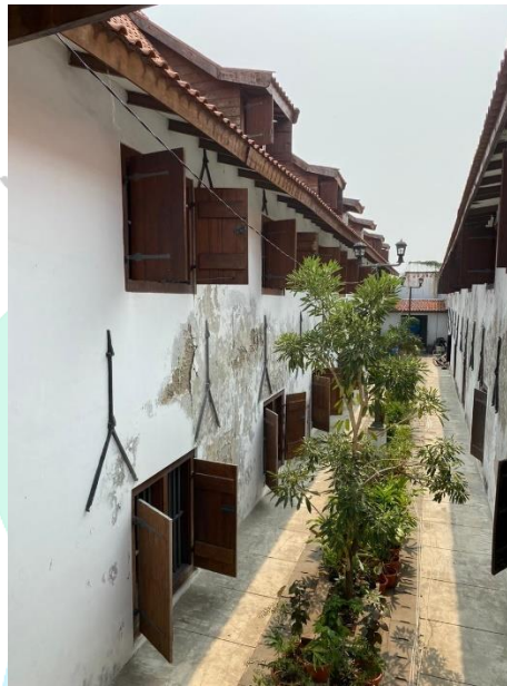
Gambar 4. 18 Material Jendela Lantai 1 dan 2
