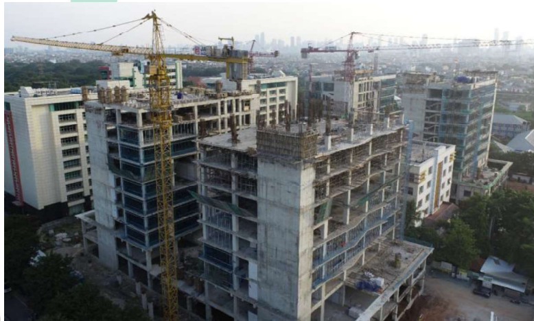
Gambar 4. 1 Proyek Pembangunan Gedung Universitas Negeri Jakarta Tower A, B, C, & D Actual Progress (Dokumen Proyek, 2023)
