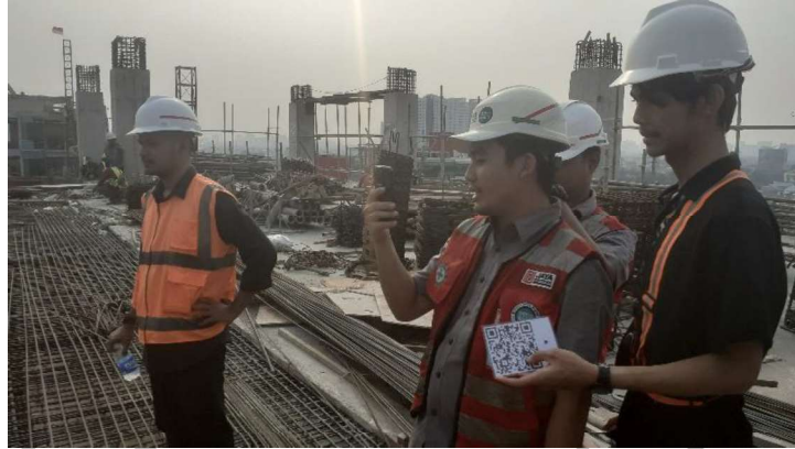
Gambar 4. 81 Pelaksanaan Uji Coba Augmented Reality pada Struktur Kolom K.C-1 It. 10 Tower C as 2.D Proyek Pembangunan Gedung Universitas Negeri Jakarta Phase 2 (Dokumentasi Pribadi, 2023)
