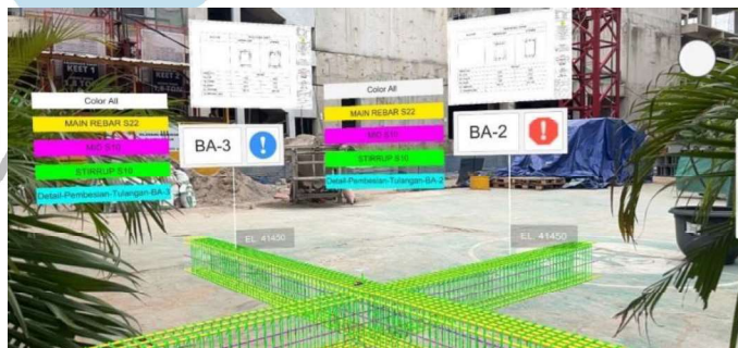
Gambar 4. 95 Visualisasi Struktur Pembesian serta Shop Drawing BA-2 dan BA-3 Berbasis Teknologi Augmented Reality (Dokumentasi Pribadi, 2023)
