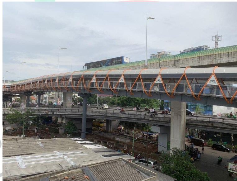
Gambar 1.1 Skybridge Stasiun Kebayoran
