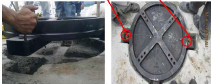
Gambar 4. 10 Proses pemasangan pelat sosrobahu (Proyek Jalan Layang MBZ)
