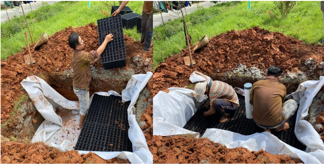
Gambar 2.5 Memasukan Magnatank dan Mengikat Dengan Kabel Ties
