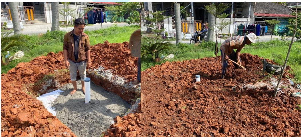
Gambar 2.6 Menutup Dengan Lapisan pasir dan tanah
