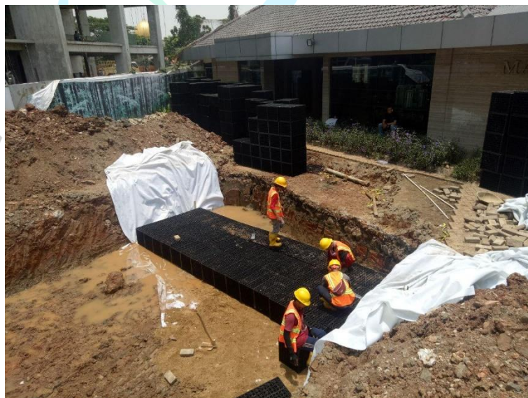
Gambar 2.11 Pemasangan Magnatank di wilayah Jakarta Selatan (Magnatank.com, 2023)
