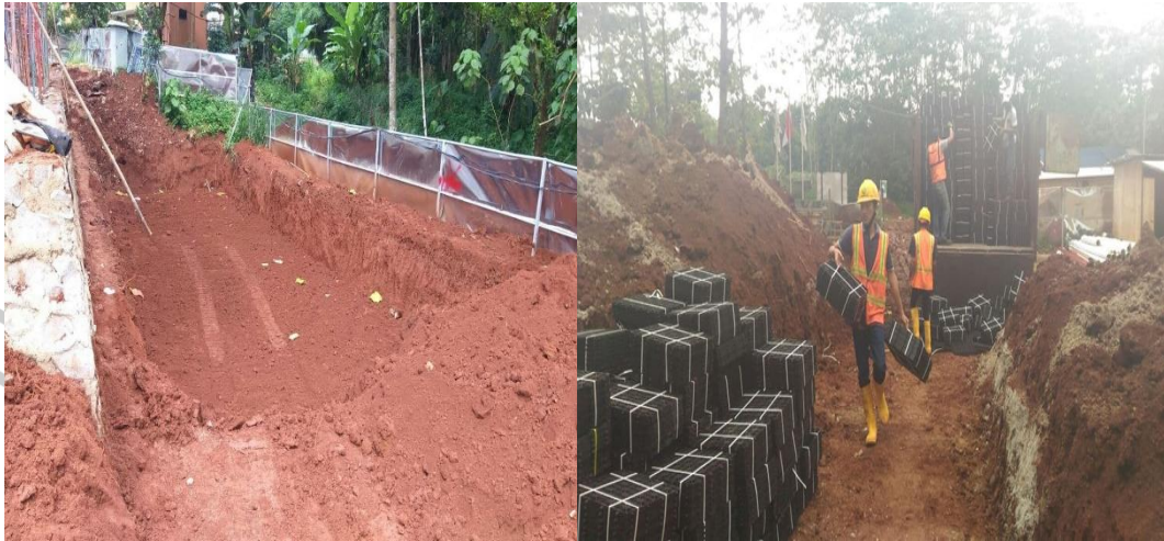
Gambar 2.3 Penggalian Tanah dan Mobilisasi Material Tangki Modular Magnatank (Magnatank.com, 2023)
