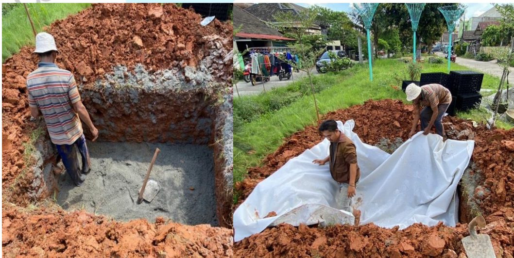
Gambar 2.4 Menggelar Pasir Urug dan Non-Woven Geotextile
