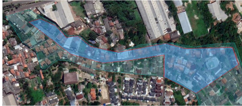
Gambar 4. 21 Limpasan Aliran Kondisi Lapangan (Google earth, 2023)
