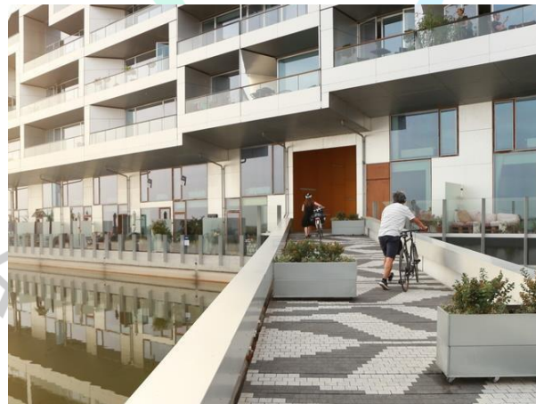
Gambar 2. 27 Aksesibilitas Bangunan 8 House, Denmark (Sumber: Archdaily.com, Diakses Pada 26-01-2023)
