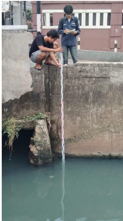
Gambar L3. 2 Pengukuran Kedalaman Sungai Serua di Perumahan Pondok Maharta (Sumber: Dokumen Pribadi, 2023)
