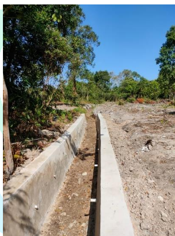
Gambar 3.3.5 Dokumentasi Kegiatan Drainase Di Belakang Kantor DPUPR
