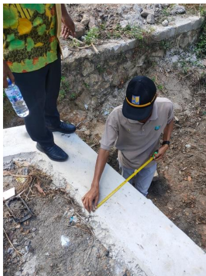
Gambar 3.3.4 Dokumentasi Kegiatan Drainase Di Belakang Kantor DPUPR
