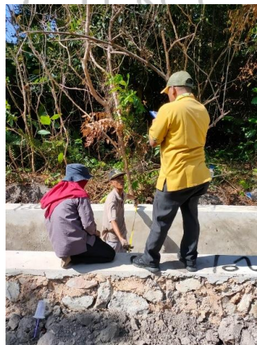
Gambar 3.3.3 Dokumentasi Kegiatan Drainase Di Belakang Kantor DPUPR
