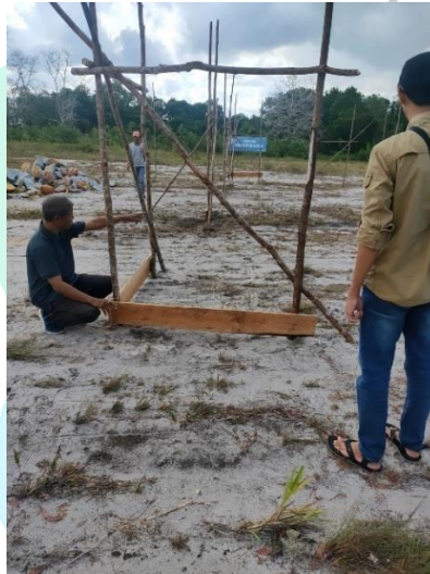
Gambar 3.2.3 Dokumentasi Penandaan Letak Pondasi
