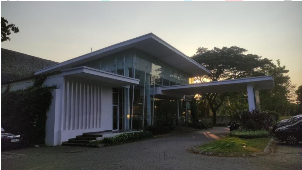
Lampiran 11 Fasad Kantor Unit Pemasaran Bintaro Jaya
