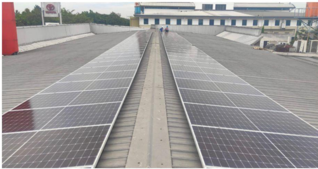
Gambar 2.3.1 PLTS On-grid 26KWp pada Astra Auto2000 Jakarta Th 2021
