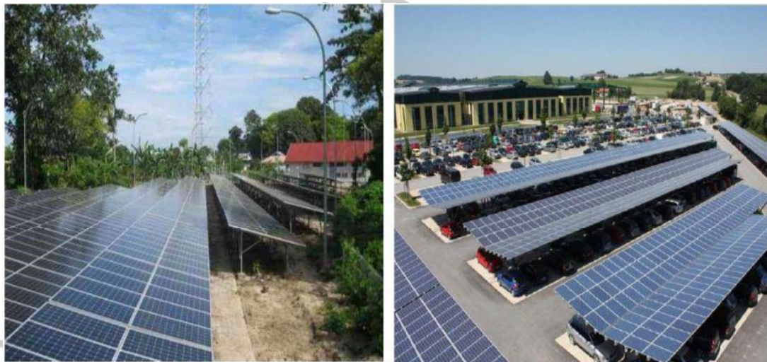
Gambar 2.3.9 Pemasangan PLTS di Parkiran (Sumber: Data Internal PT Indosolar Energi Mandiri)
