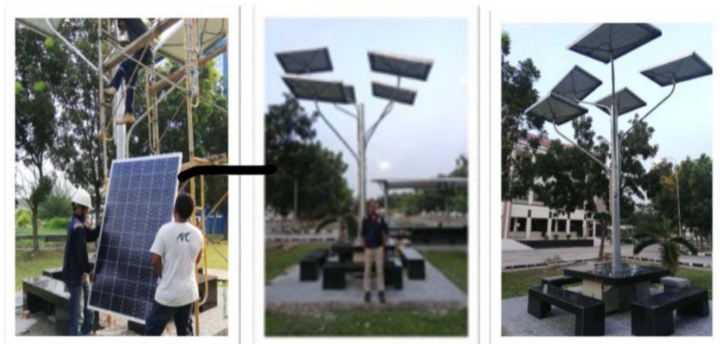
Gambar 2.3.10 Pemasangan PLTS di Taman (Sumber: Data Internal PT Indosolar Energi Mandiri)
