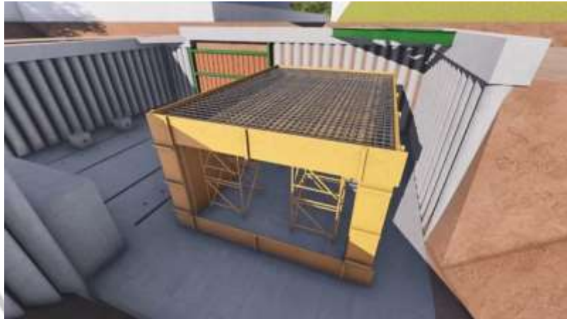
Gambar 3. 26 Instalasi Top Slab Box Tunnel Sumber : (Dokumen PT. Jaya Konstruksi, 2021)
