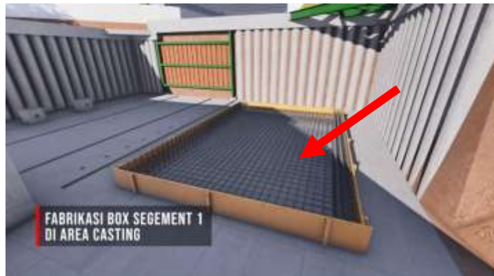
Gambar 3. 24 Instalasi Bottom Slab Box Tunnel Sumber : (Dokumen PT. Jaya Konstruksi, 2021)
