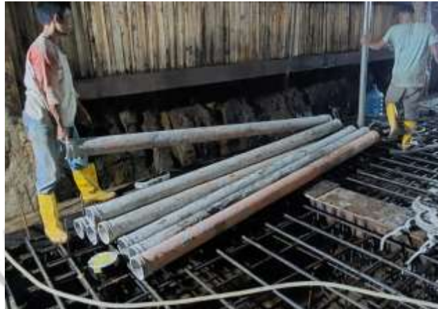
Gambar 3. 10 Concrete Pump Sumber : (Dokumen PT. Jaya Konstruksi, 2021)
