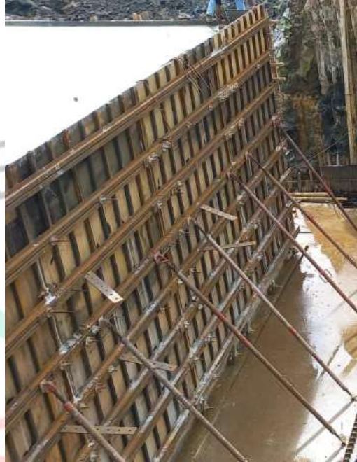
Gambar 3. 17 Bekisting Box tunnel Sumber : (Dokumentasi Pribadi)
