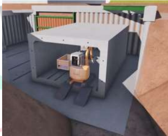
Gambar 3. 42 Excavator Sudah Berada di Dalam Box Sumber : (Dokumen PT. Jaya Konstruksi, 2021)
