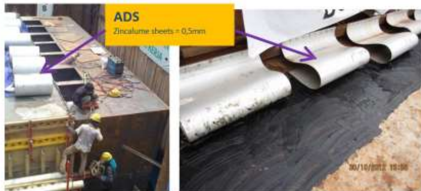
Gambar 3. 36 ADS (Anti Drag System) Sumber : (Dokumen PT. Jaya Konstruksi, 2021)
