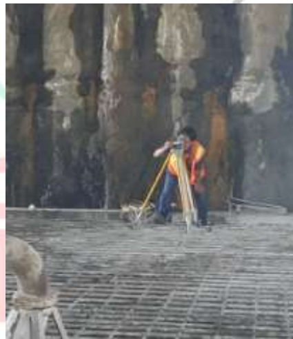
Gambar 3. 6 Theodolit Sumber : (Dokumen PT. Jaya Konstruksi, 2021)
