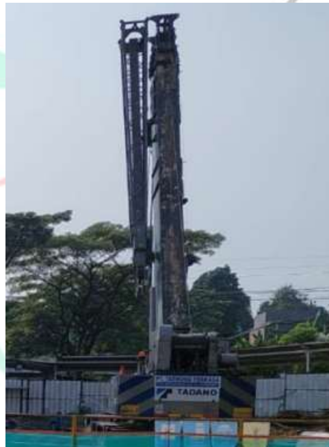
Gambar 3. 16 Mobile Crane Sumber : (Dokumen PT. Jaya Konstruksi, 2021)
