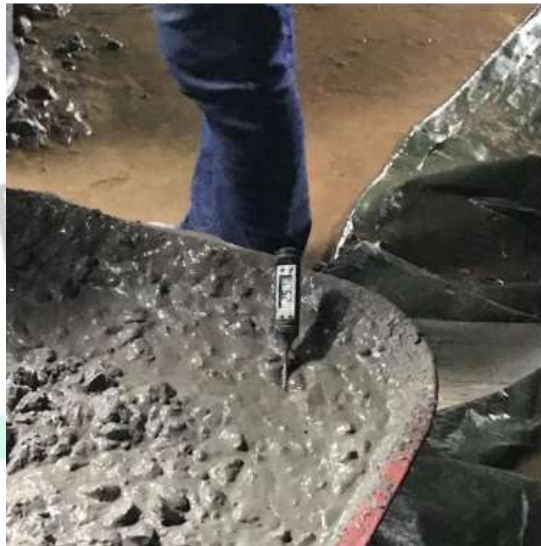
Gambar 3. 19 Beton Ready Mix Sumber : (Dokumentasi Pribadi)
