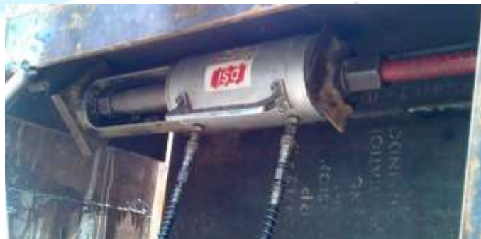
Gambar 3. 43 Stressing PT Bar Nose Blade Sumber : (Dokumen PT. Jaya Konstruksi, 2021)
