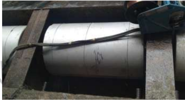
Gambar 3. 44 ADS Telah Terpasang Sumber : (Dokumen PT. Jaya Konstruksi, 2021)
