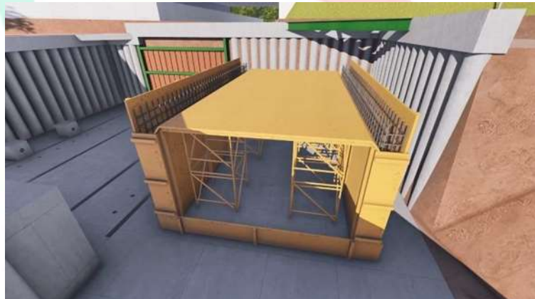
Gambar 3. 25 Instalasi Web Slab Box Tunnel Sumber : (Dokumen PT. Jaya Konstruksi, 2021)
