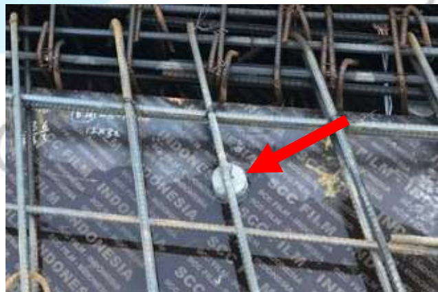
Gambar 3. 21 Beton Decking Sumber : (Dokumentasi Pribadi)
