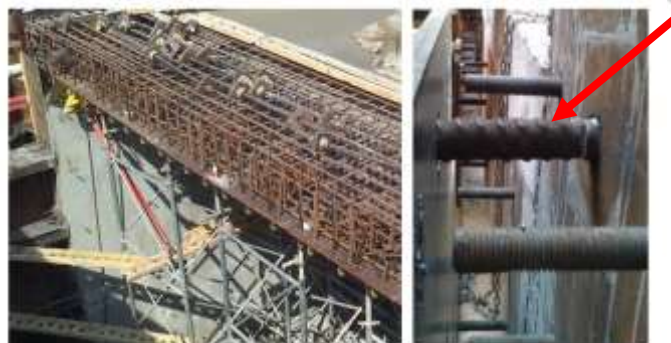
Gambar 3. 38 PT Bar dan HTB Sumber : (Dokumen PT. Jaya Konstruksi, 2021)
