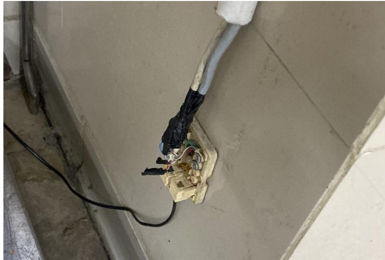
gambar 3. 34 Kabel Telepon putus
