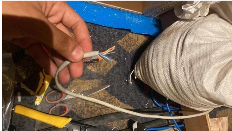
gambar 3.7 Praktikan saat melakukan crimping
