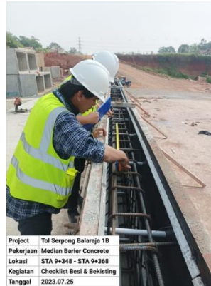
Gambar 2. 14 Checklist dimensi pembesian Median Barrier (Source : Dokumentasi pribadi)
