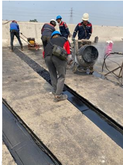
Gambar 2. 18 Proses pekerjaan Asphaltic Plug pada ramp Legok (Source : Dokumentasi pribadi)
