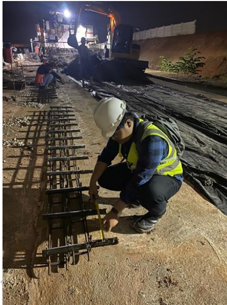
Gambar 2. 7 Checklist dimensi dowel pekerjaan rigid pavement (Source : Dokumentasi pribadi)
