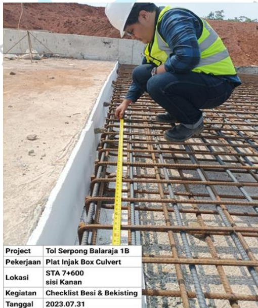
Gambar 2. 8 Checklist dimensi pembesian Plat Injak Box Culvert (Source : Dokumentasi pribadi)
