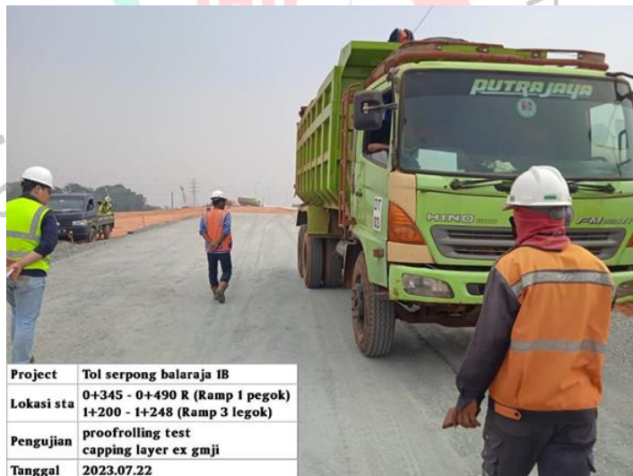
Gambar 2. 13 Pengujian Proofrolling Test (Source : Dokumentasi pribadi)
