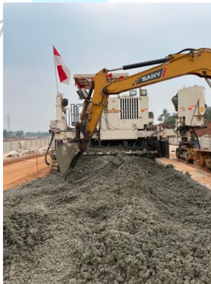
Gambar 3. 17 Pemerataan concrete menggunakan excavator dan pemadatan menggunakan slipform paver (Source : Dokumentasi pribadi)
