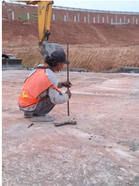
Gambar 3. 13 Pemasangan Stringline & Stick elevasi (Source : Dokumentasi pribadi)
