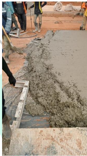
Gambar 3. 20 Pemasangan cetakan start cor (Source : Dokumentasi pribadi)
