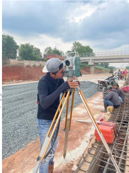
Gambar 3. 12 Steking out dari Lean concrete untuk pekerjaan Rigid pavement (Source : Dokumentasi pribadi)
