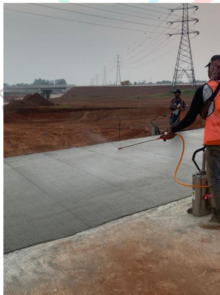
Gambar 3. 24 Penyiraman Curing (Source : Dokumentasi pribadi)
