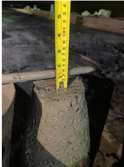
Gambar 3. 16 Pengujian Slump pada concrete yang baru dihampar oleh Dump truk (Source : Dokumentasi pribadi)
