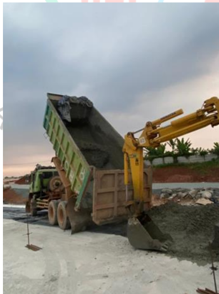
Gambar 3. 15 Penghamparan concrete dari Dumptruck (Source : Dokumentasi pribadi)
