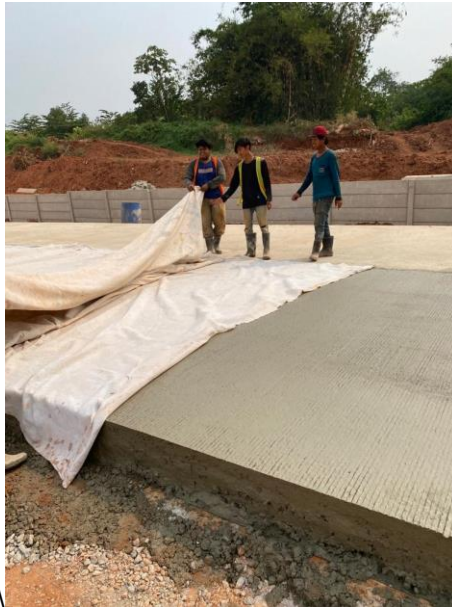
Gambar 3. 23 Pemasangan geotex untuk menghindari hidrasi akibat panas matahari (Source : Dokumentasi pribadi)
