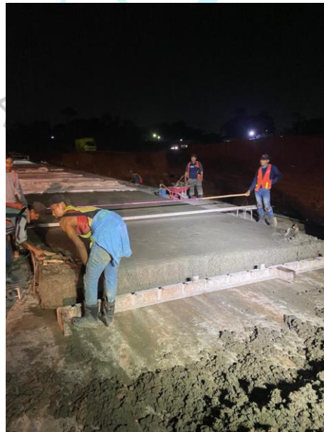
Gambar 3. 27 Pemasangan cetakan Stop Cor (Source : Dokumentasi pribadi)
