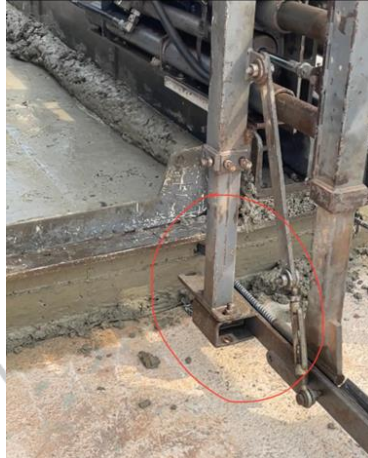
Gambar 3. 18 Pemasangan Tie Bar otomatis (Source : Dokumentasi Pribadi)
