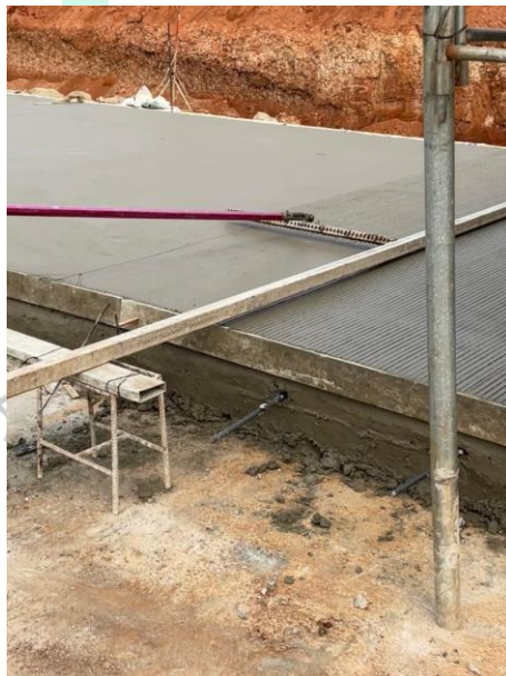
Gambar 3. 22 Proses pekerjaan grooving (Source : Dokumentasi pribadi)
