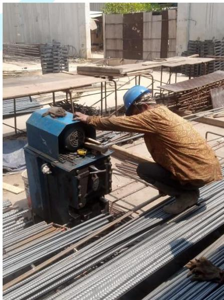
**Gambar 3. 30 Proses Pemotongan Besi**
