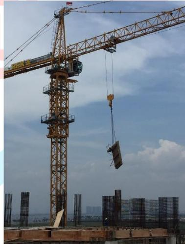
**Gambar 3. 41 Pengangkatan Bekisting Dinding Geser**
