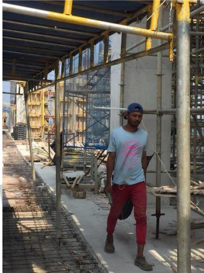
**Gambar 3. 56 Pekerja Tanpa Alat Pelindung Diri**
