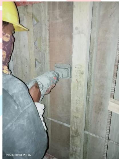
**Gambar 3. 52 Pemasangan Beton Dinding Geser Menggunakan Vibrator**
