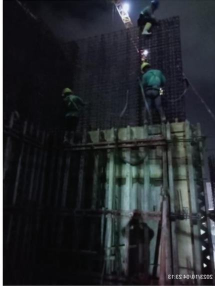
**Gambar 3. 38 Perbaikan Pemesian Dinding Geser**
