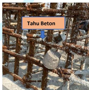
**Gambar 3. 36 Proses Pemasangan Tahu Beton**
