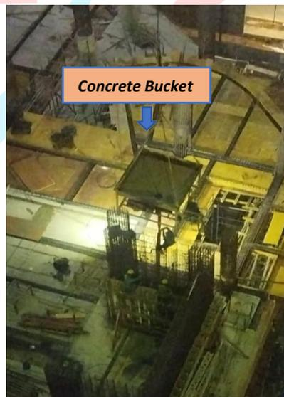
**Gambar 3. 50** Pengangkatan Concrete Bucket ke Lokasi Pengecoran
