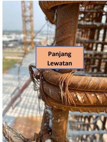
**Gambar 3. 35 Proses Pemasangan Panjang Lewatan**
