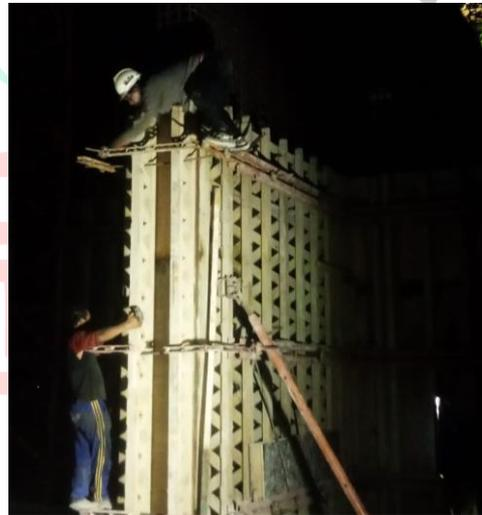
**Gambar 3. 45 Proses Pengencangan Bekisting**
