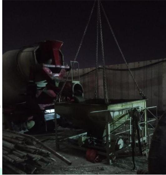
**Gambar 3. 49** Penuangan Beton Ready Mix ke dalam Concrete Bucket
