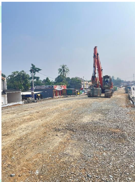
Gambar 3.22 Pemadatan Tanah dengan alat berat
