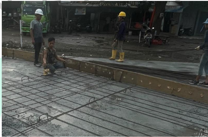
Gambar 3.23 Pemasangan Bekisting Cor
