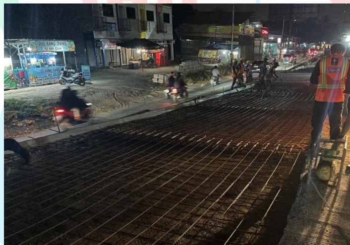
Gambar 3.25 Hasil Pekerjaan Pembesian
