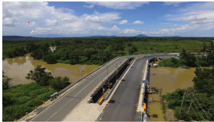
Gambar 2. 2 Jembatan Lingkar Batulicin (Sumber : Dokumen PT Pandji Bangun Persada)
