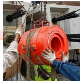
Gambar 3. 26 Hydraulic Jack SA 507 / ZPE - 7/ A(7S)
