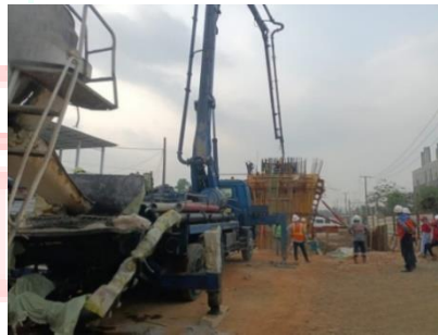
Gambar 3. 37 Pengecoran Pier
