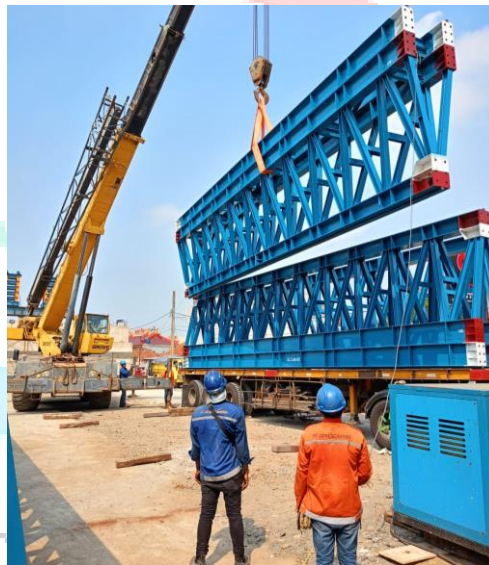
Gambar 3. 40 Mobilisasi Launcher
