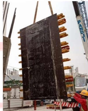
Gambar 3. 35 Pemasangan Bekisting
