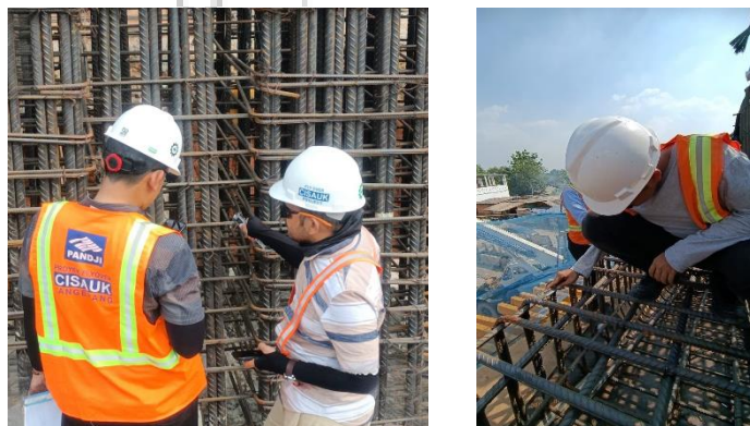
Gambar 3. 34 Checklist Pembesian Pier dan Pier Head
