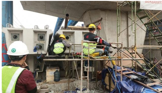
Gambar 3. 43 Prestressing (Sumber : Dokumentasi Pribadi)
