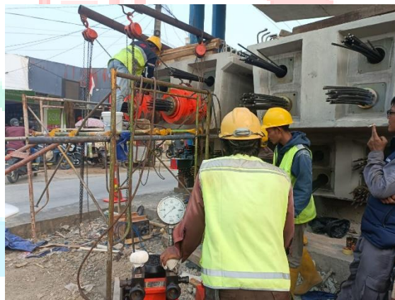
Gambar 3. 44 Stressing (Sumber : Dokumentasi Pribadi)
