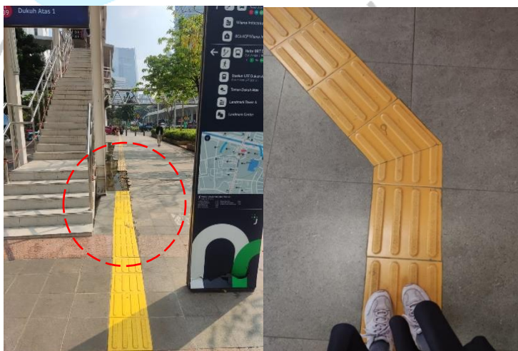
Gambar 4. 11. Penerapan ubin pemandu yang tidak baik Sumber: Olahan Pribadi, 2023
