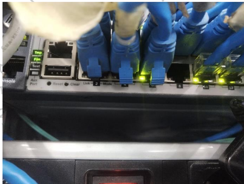
gambar 3. 5 contoh jaringan pada switch pada port 2 dan 4 yang mati
