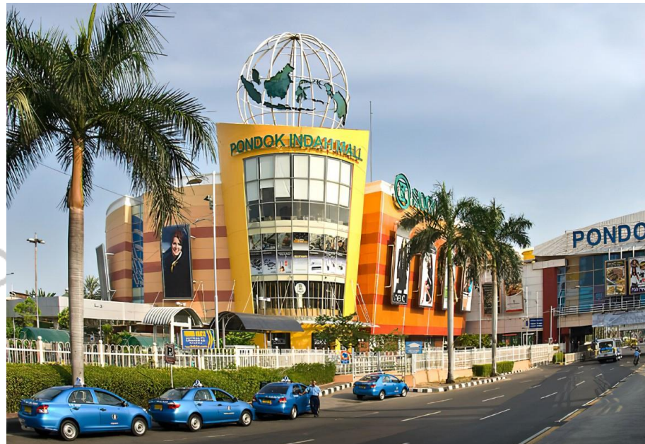
Gambar 2. 4 Pondok Indah Mall
