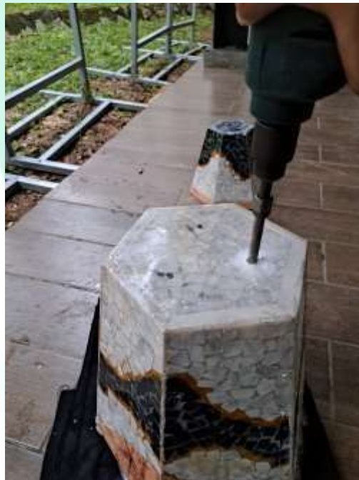
Gambar 4.19 Proses pemboran
