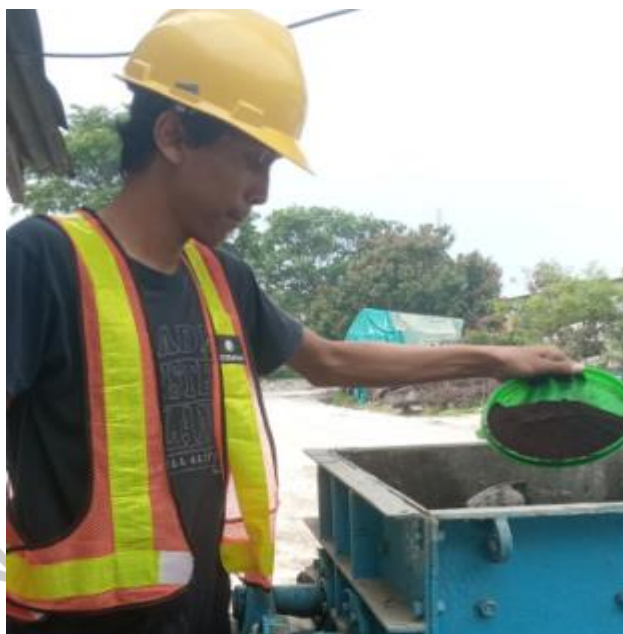
Gambar 4. 3 Proses Pembuatan Beton
