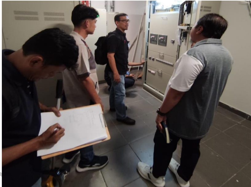
Gambar 3. 8 Survei Pusat Listrik Kantor Pusat ASDP
