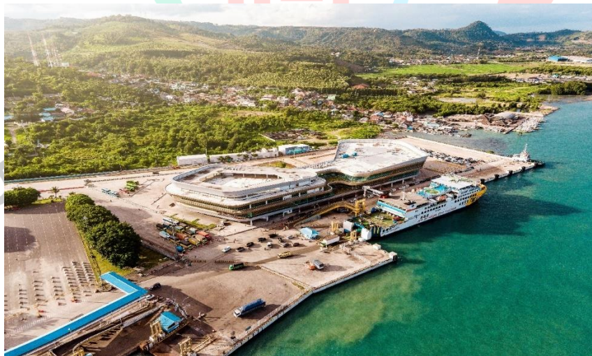
Gambar 2. 10 Pelabuhan PT. ASDP Indonesia Ferry (Persero)
