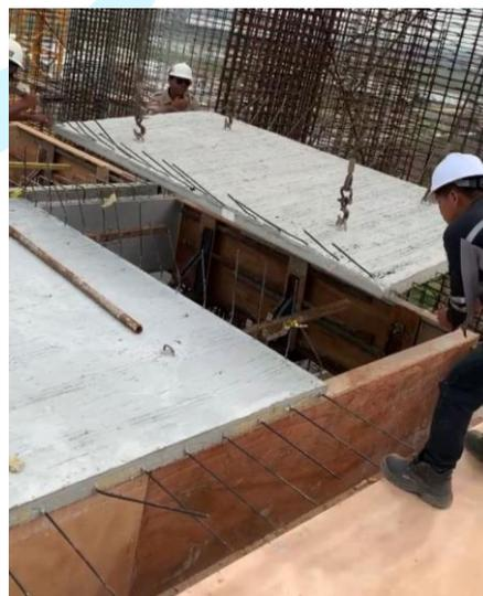
Gambar 3. 24 Pemasangan Bekisting
