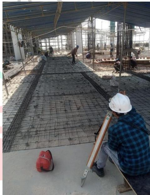
Gambar 3. 25 Pekerjaan *Levelling*
