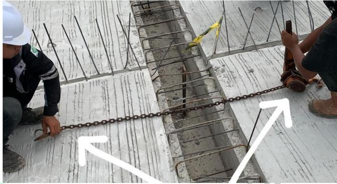
Gambar 3. 29 Perapatan *Precast* dengan alat *Lever Block*
