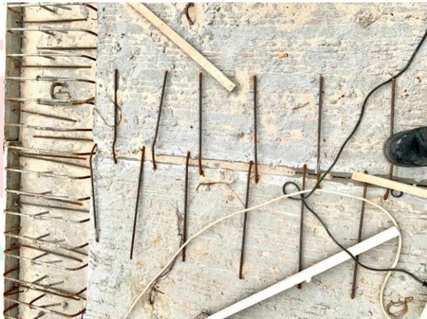
Gambar 3. 30 *Precast* setelah dirapatkan
