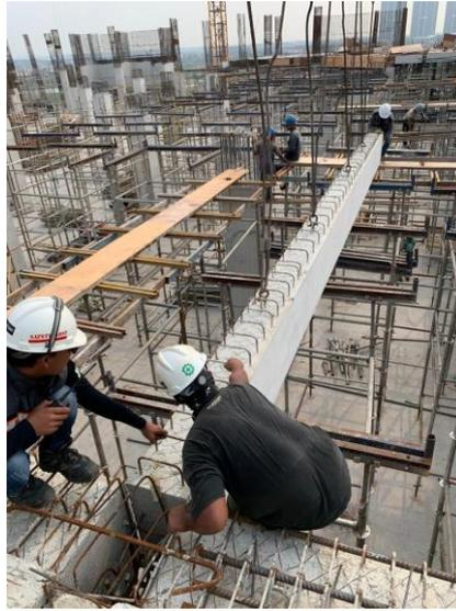
Gambar 3. 27 Pemasangan Balok *Precast*
