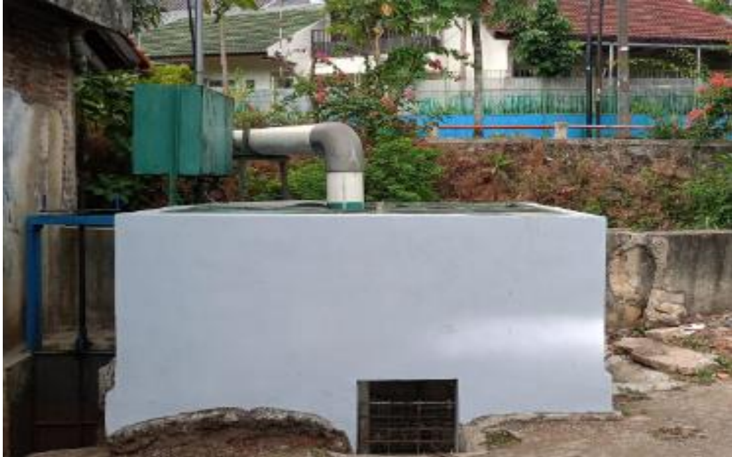
Gambar 1. 3 Gambar Bangunan Pompa Banjir
