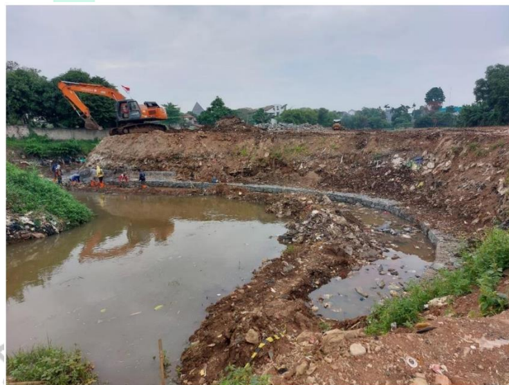
Gambar 3. 19 Pemasangan dinding penahan tanah (DPT) Bronjong untuk bagian sisi Sungai Grogol
