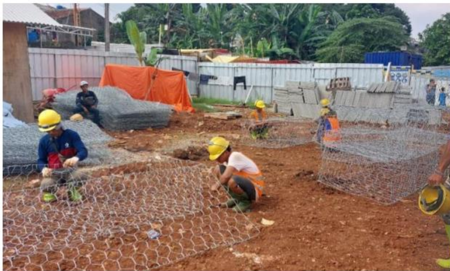
Gambar 3. 17 Fabrikasi rangka kawat Dinding Penahan Tanah (DPT) Bronjong
