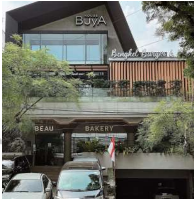
Gambar 1 1 Bangunan Restoran ( Sumber : Karens Diner )
