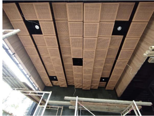
Gambar 3.9 Proses Pekerjaan Revisi Plafon Interior Sumber : Dokumentasi pribadi
