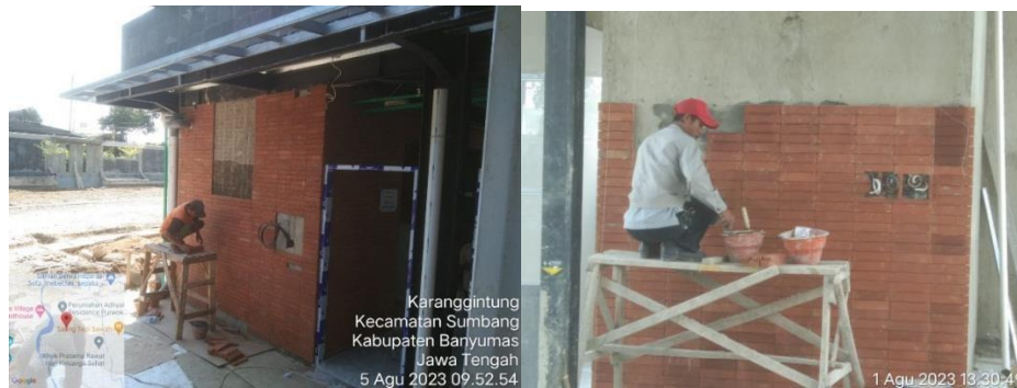
Gambar 4.11 Pemasangan Bata Tempel Area Toilet Caffe Sumber : Dokumentasi pribadi
