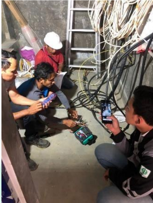
Gambar 3.4 Pengecekan Tes Megger Jalur Kabel Sumber : Dokumentasi Pribadi
