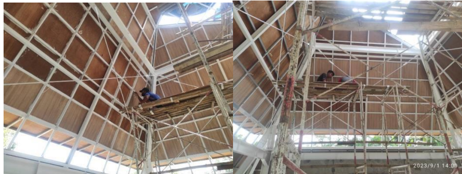
Gambar 3.13 Rangka Hollow Mushola Sumber : Dokumentasi pribadi
