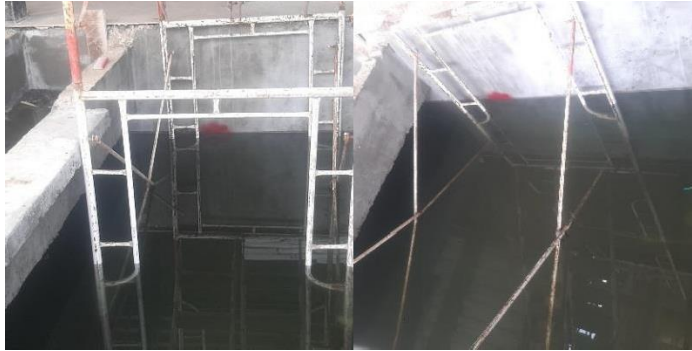
Gambar 3.14 Area Kolam Air Sumber : Dokumentasi pribadi
