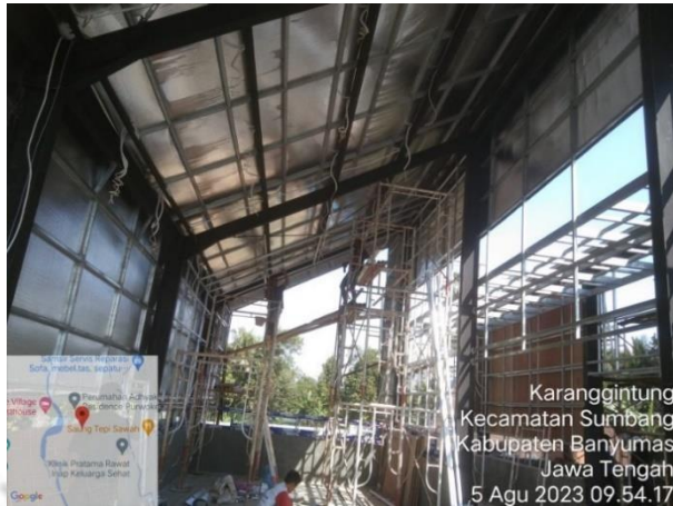
Gambar 3.5 Pengawasan MEP lantai 2 Sumber : Dokumentasi Pribadi
