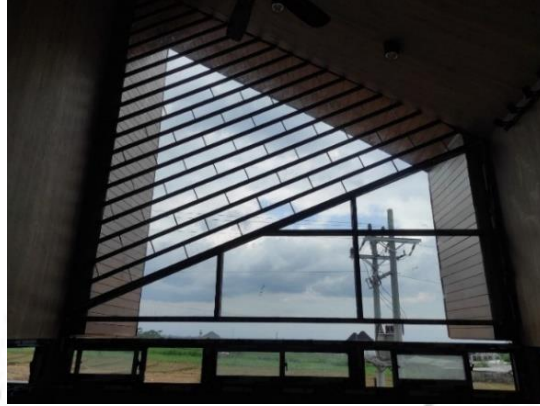
Gambar 3.18 Rangka Aluminium Kaca Sumber : Dokumentasi pribadi
