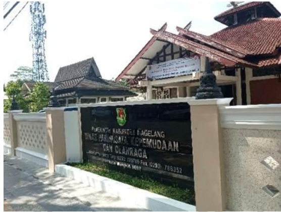
Gambar III.1 Gedung Disparpora Kabupaten Magelang
