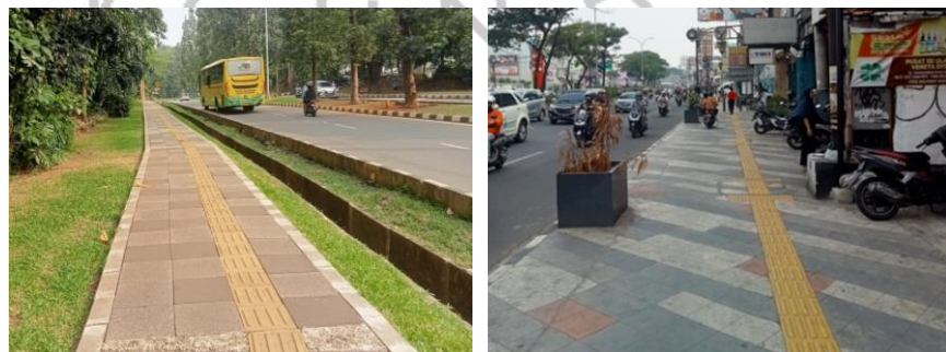
Gambar 4.2. 1 Trotoar seberang RIK UI dan Trotoar Jl. Margonda Raya (Sumber: dokumentasi pribadi)
