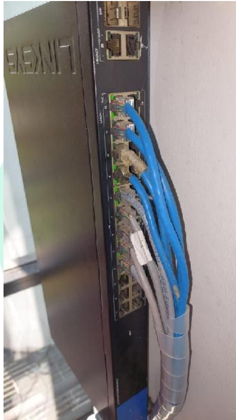
Gambar 3.11 switch yang sudah dipasangkan ke kabel LAN yang diperbaiki.
