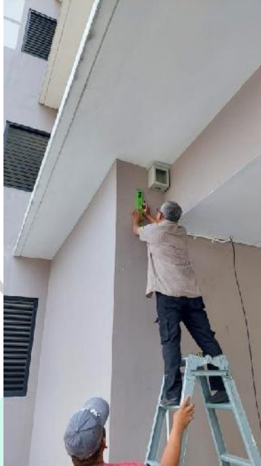
Gambar 3.34 Pengukuran pemasangan oleh teknisi untuk access point yang akan digunakan.
