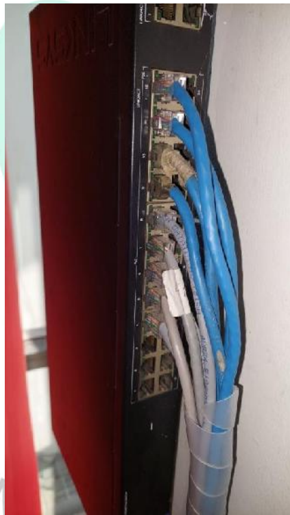
Gambar 3.10 Pemasangan kabel LAN baru pada switch .
