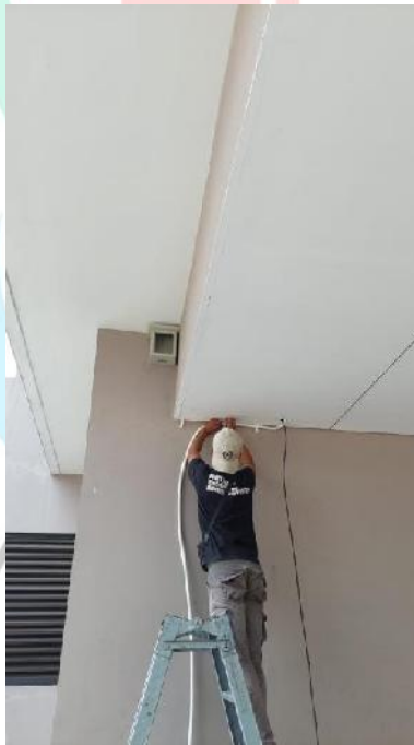
Gambar 3.33 Penataan kabel oleh teknisi untuk access point yang akan digunakan.
