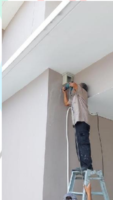
Gambar 3.35 Pengeboran pemasangan oleh teknisi untuk access point yang akan digunakan.
