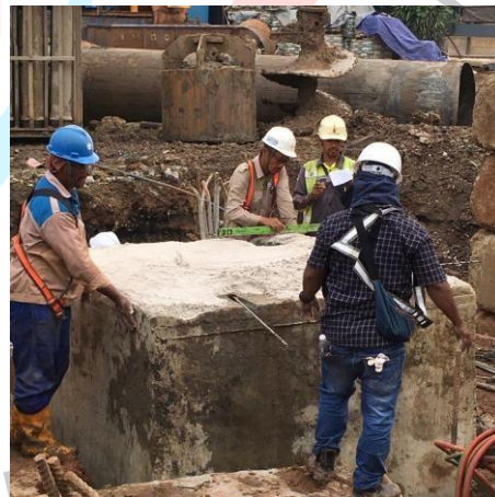
Gambar 3. 97 Pemberian pasir pada top pile cap
