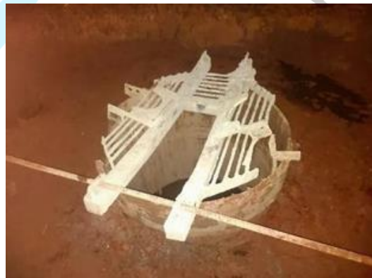
Gambar 3. 62 Peletakan clamp di atas casing
