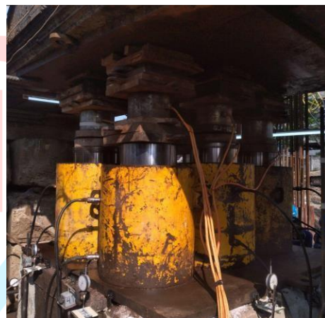
Gambar 3. 109 Susunan penempatan 6 hydraulic jack
