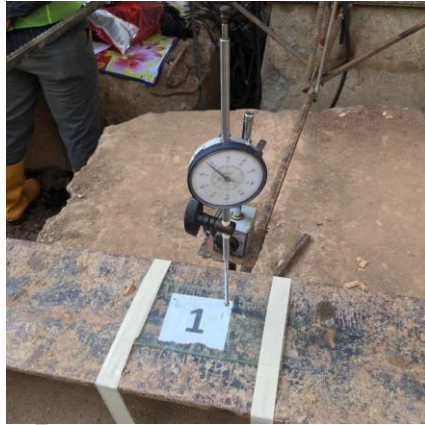
Gambar 3. 100 Pemasangan dial gauges untuk membaca penurunan test pile utama
