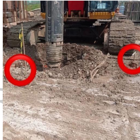
Gambar 3. 21 Titik offset peg
