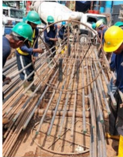
Gambar 3. 52 Pemasangan tulangan utama
