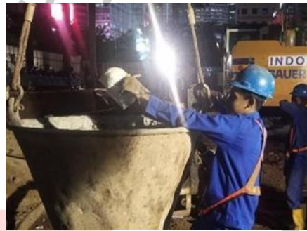
Gambar 3. 73 Proses pemasukan styrofoam
