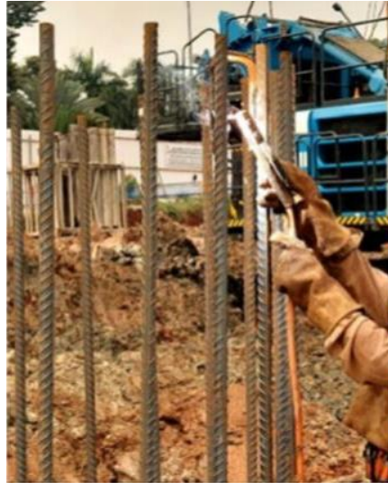
Gambar 3. 59 Pengelasan gantungan
