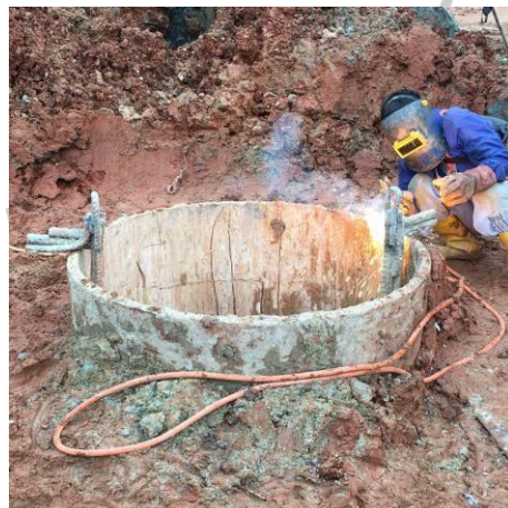
Gambar 3. 61 pengelasan top stopper pada top casing
