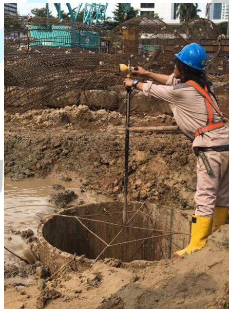
Gambar 3. 29 Pengecekan titik koordinat Drilling
