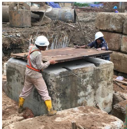
Gambar 3. 98 Pemberian plat baja pada top pile cap
