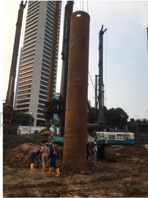
Gambar 3. 26 Pemasangan casing
