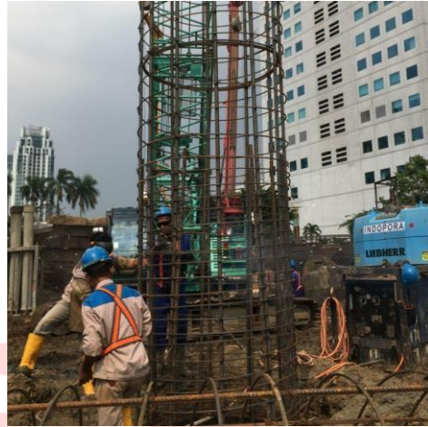
Gambar 3. 58 Pengelasan besi tulangan antar section
