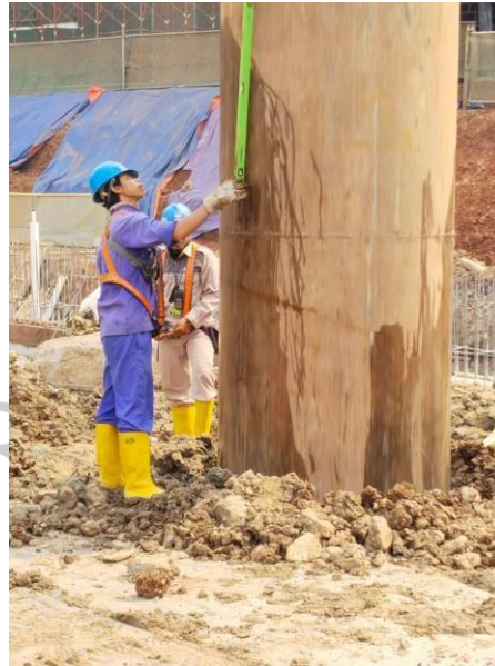
Gambar 3. 28 Cek Vertikalisasi
