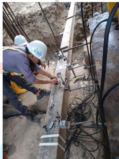
Gambar 3. 104 Pemasangan dial gauges pada reference beam
