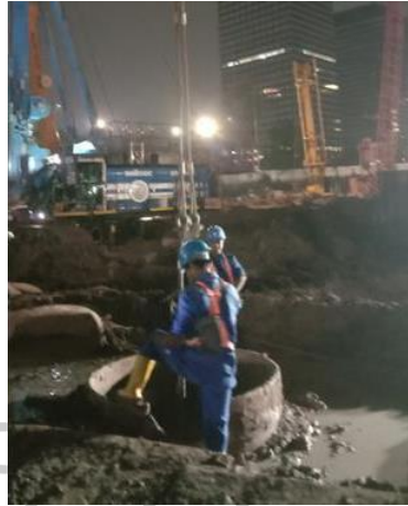
Gambar 3. 77 Pelepasan stopper
