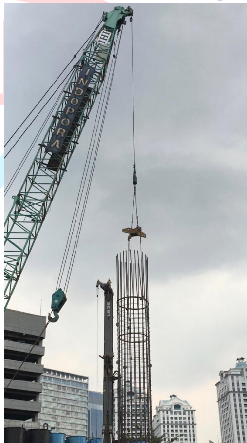
Gambar 3. 57 Pengangkatan tulangan bored pile yang telah dirakit menggunakan crawler crane
