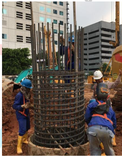
Gambar 3. 60 Pemasangan stopper
