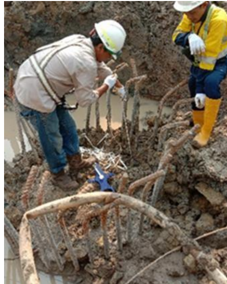
Gambar 3. 81 Mengukur kedalaman pile
