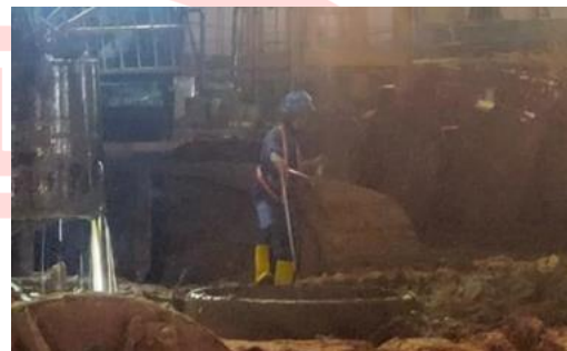
Gambar 3. 31 Pengecekan kedalaman penggalian menggunakan meteran kain 100 m
