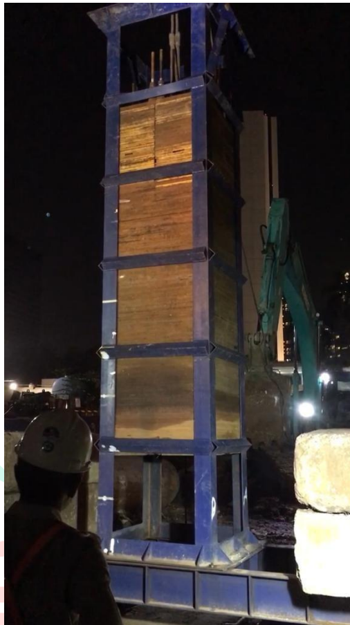
Gambar 3. 90 Pengangkatan palu untuk test PDA
