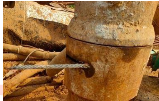
Gambar 3. 64 Pemasangan wire cable pada sambungan pipa tremie
