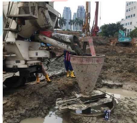
Gambar 3. 74 Penuangan beton
