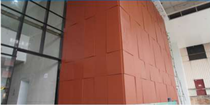
PEKERJAAN GRC CETAK MOTIF TERACOTTA AREA DRIVEWAY
