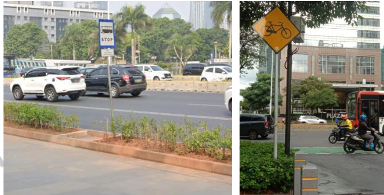
Gambar 4 12 Kondisi rambu jalur pejalan kaki
