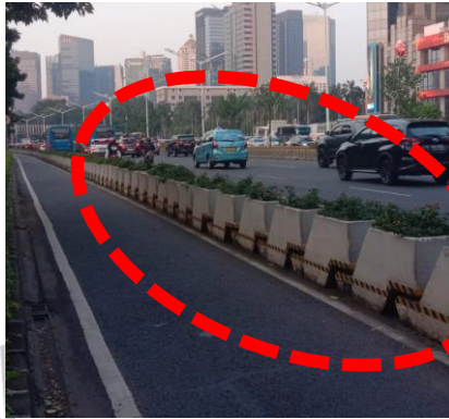
Gambar 4 13 Kondisi pembatas fisik jalur sepeda
