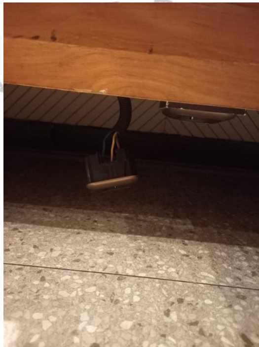
Gambar 3. 7 Stopkontak bermasalah Sumber : Internal Starbucks Sektor 7
