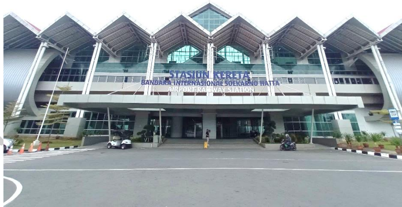
Gambar 2. 7 Tampak Luar Stasiun KA Bandara Soekarno-Hatta
