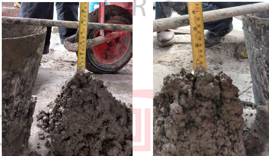
Gambar 4. 6 Uji Slump pada Beton
