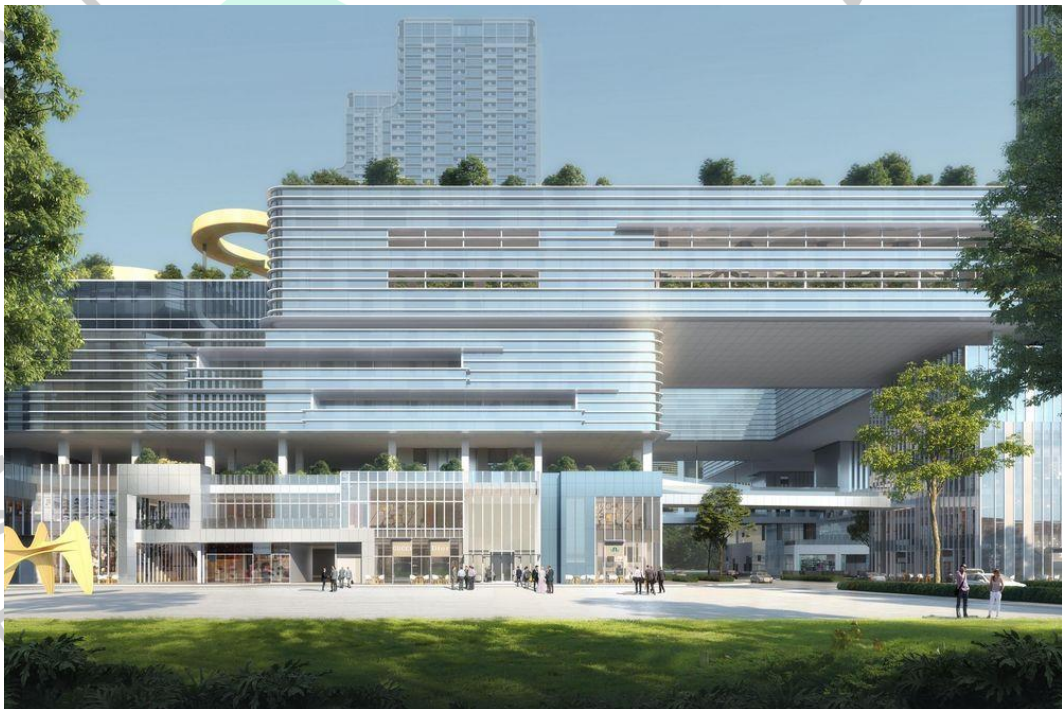
Gambar 2.8 Keterhubungan antar massa bangunan Nanshan Science & Technology Sumber : (HPP, 2024)
