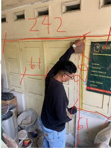
**Gambar 17. Pengukuran detail pintu dan jendela depan**
