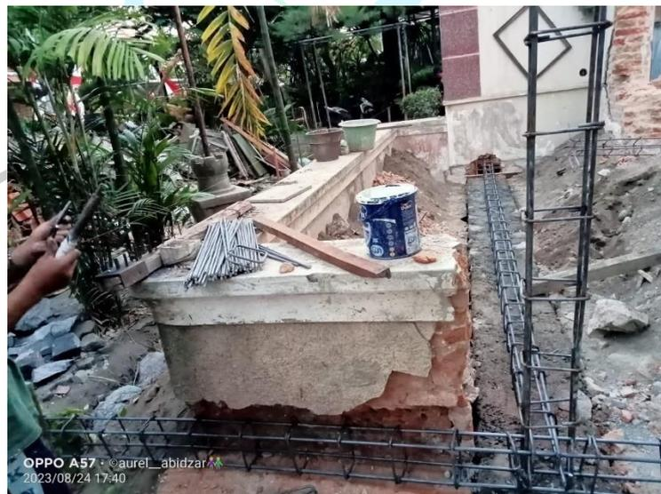
**Gambar 30. Proses pembesian untuk sloof dan kolom pada dinding fasad**
