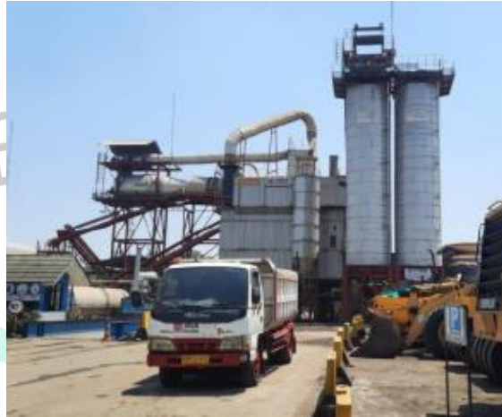
Gambar 3. 20 Proses Produksi Campuran Aspal pada Asphalt Mixing Plant
