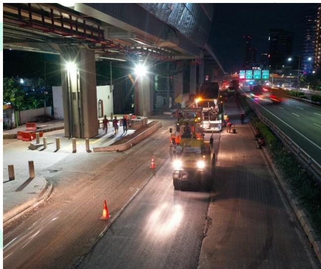
Gambar 3. 25 Proses Pemadatan Aspal (Sumber: Dokumen Proyek Jalan Rasuna Said, 2023)
