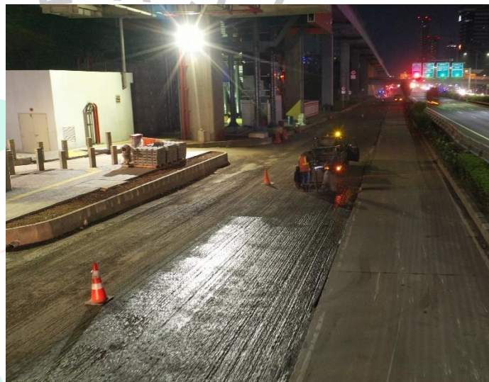
Gambar 3. 23 Proses Penggelaran Aspal (Sumber: Dokumen Proyek Jalan Rasuna Said, 2023)
