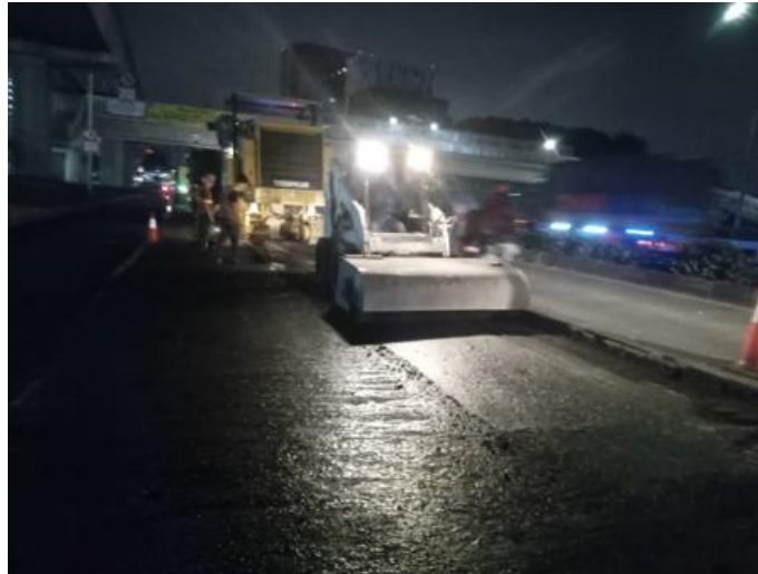
Gambar 3. 21 Proses Scrapping Menggunakan Cold Milling Machine
