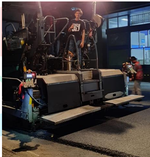
Gambar 3. 15 Asphalt Finisher (Sumber: Dokumen Pribadi, 2023)
